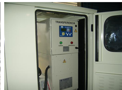
Detalle de Transferencia
