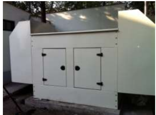
Instalación de Caseta Acústica.
